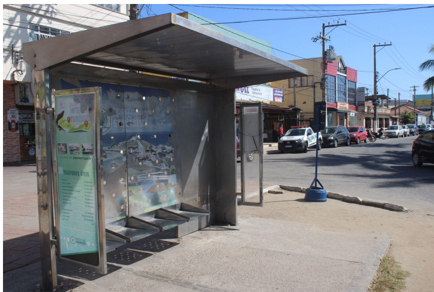
Figura 56 - Exemplos de abrigos de ônibus de Saquarema
