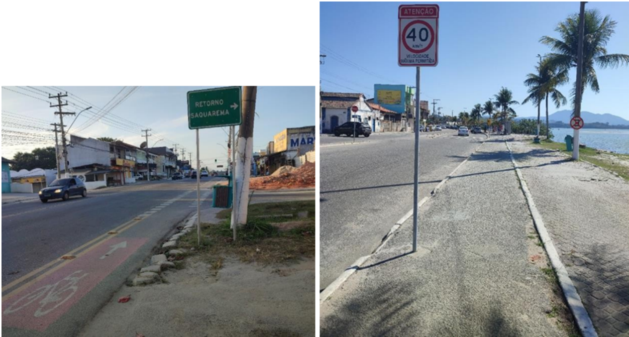
Figura 45 - Trecho da ciclofaixa da Av. Saquarema e da ciclovia na Av. Beira Mar
