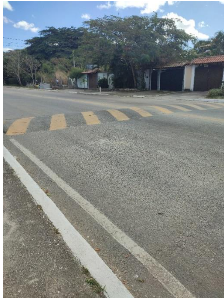
Figura 3 - Pavimento asfáltico (Avenida Vila Mar)
