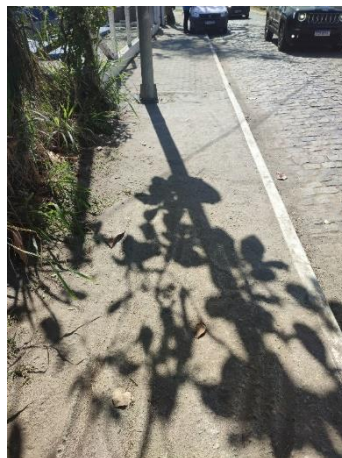
Figura 17 – Acessibilidade ruim (Rua Roberto Silveira)
