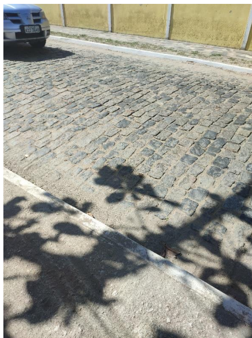
Figura 5- Calçamento de pedra (Rua Roberto Silveira)
