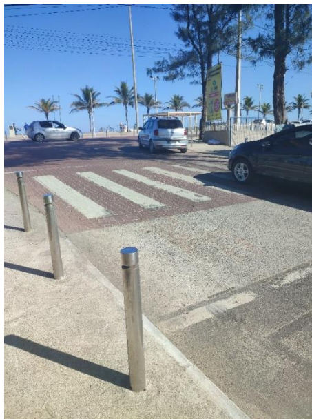
Figura 4- Pavimento intertravado (Avenida Beira Mar)
