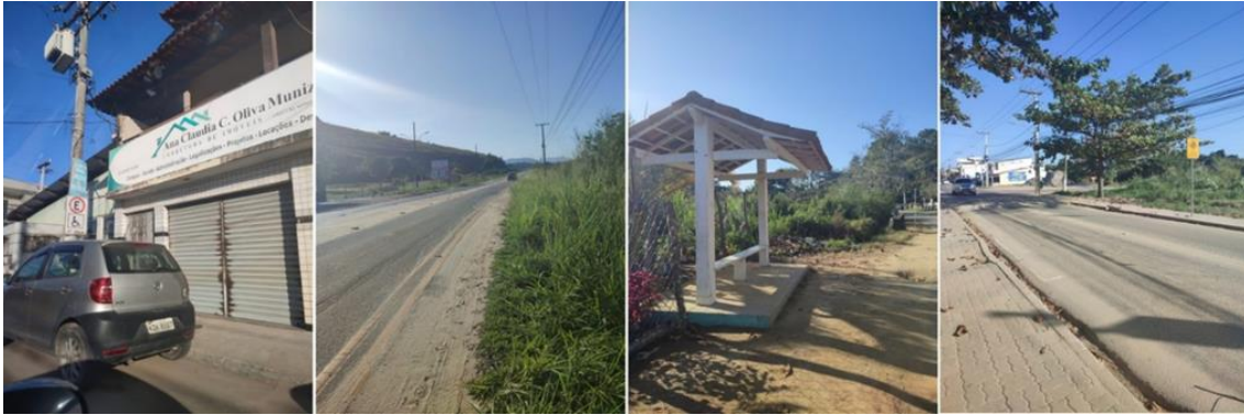
Figura 116 - Trechos da Av. Noventa e Seis
