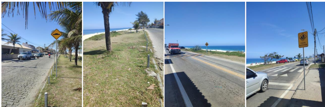
Figura 120 - Trechos da Av. Ministro Salgado Filho
