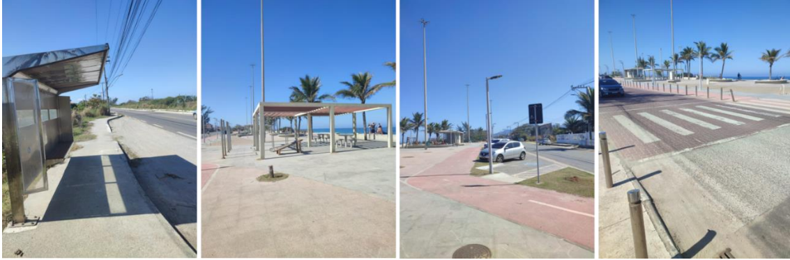
Figura 118 - Trechos da Av. Noventa e Seis
