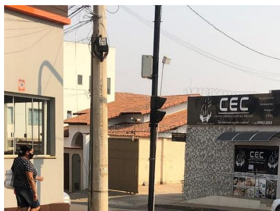
Figura 10 - Equipamento em via urbana
